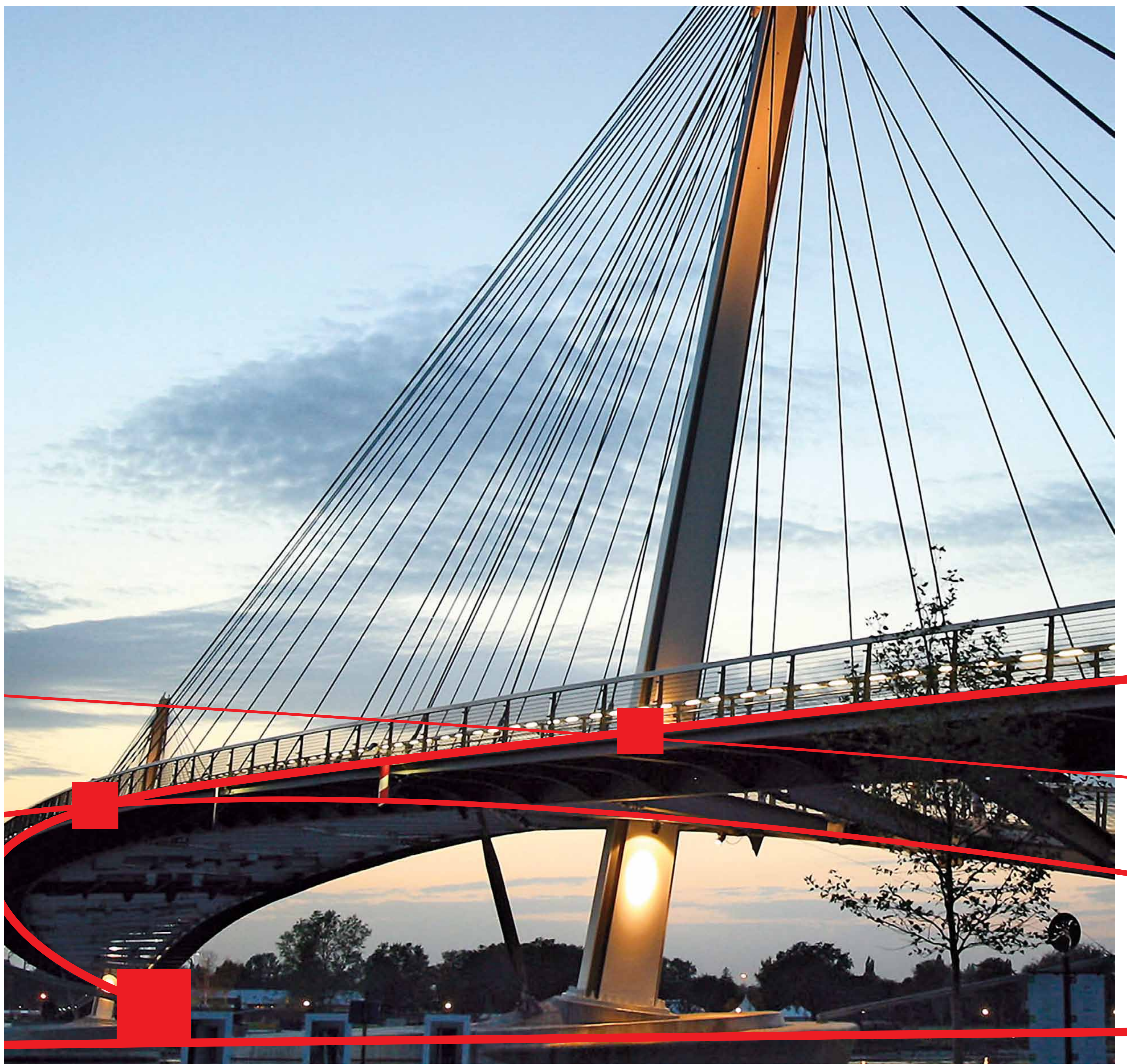
Passerelle des deux Rives entre Kehl et Strasbourg (Stadt Kehl/Peter Heck)
